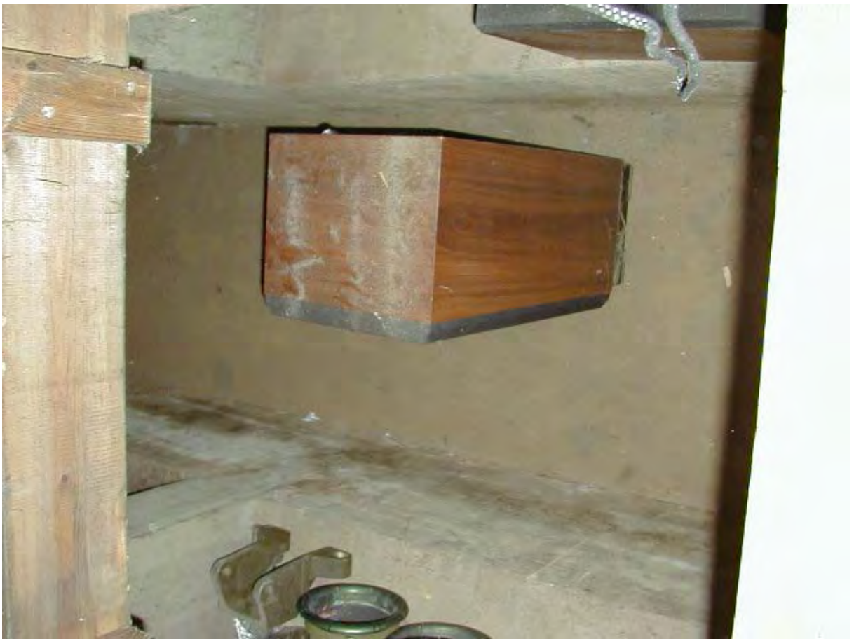
GHK27 Nedlagt smøregrav (bygning 107).
