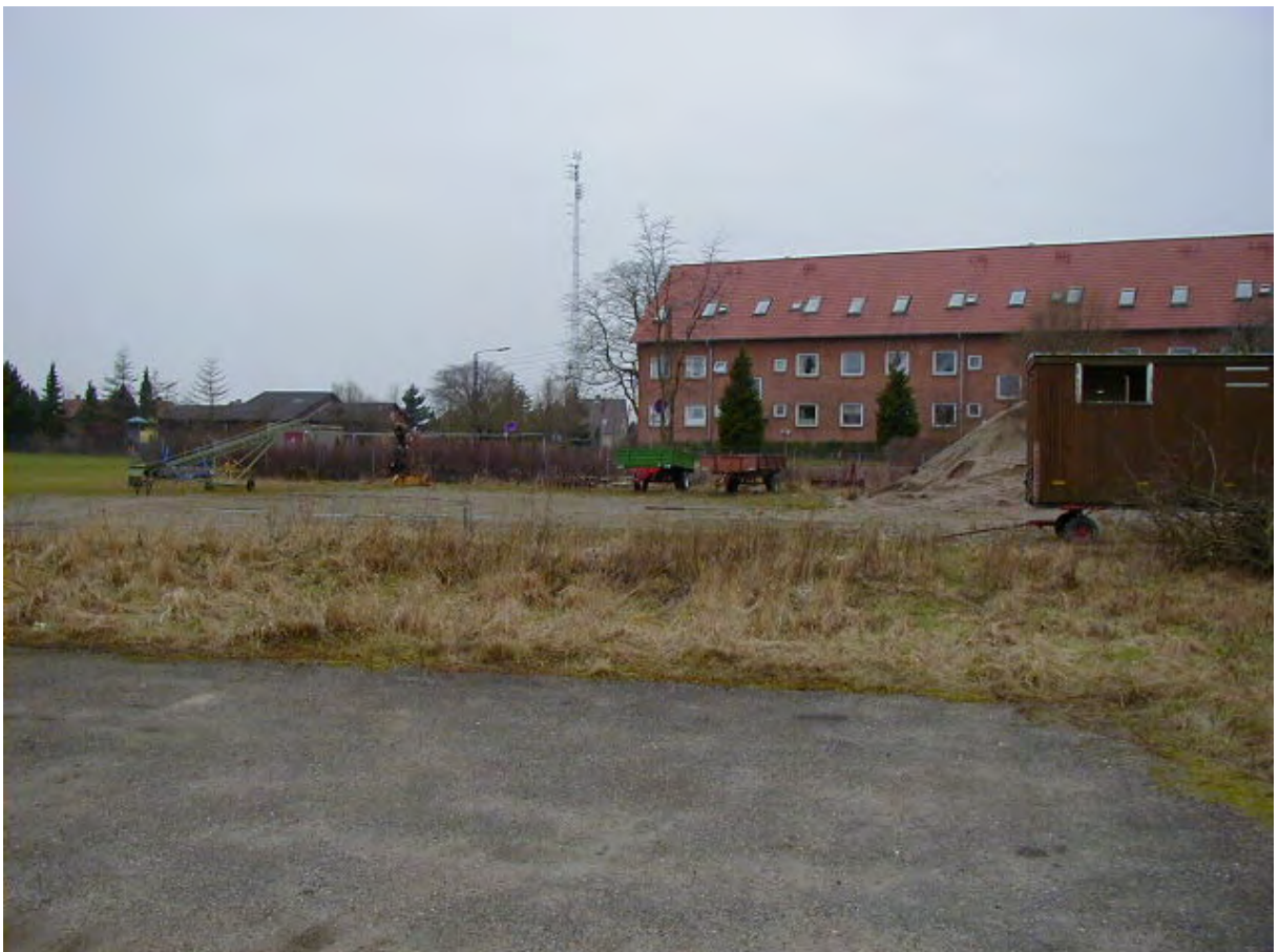
GHK18 Materialeplads (ved bygning 108).
