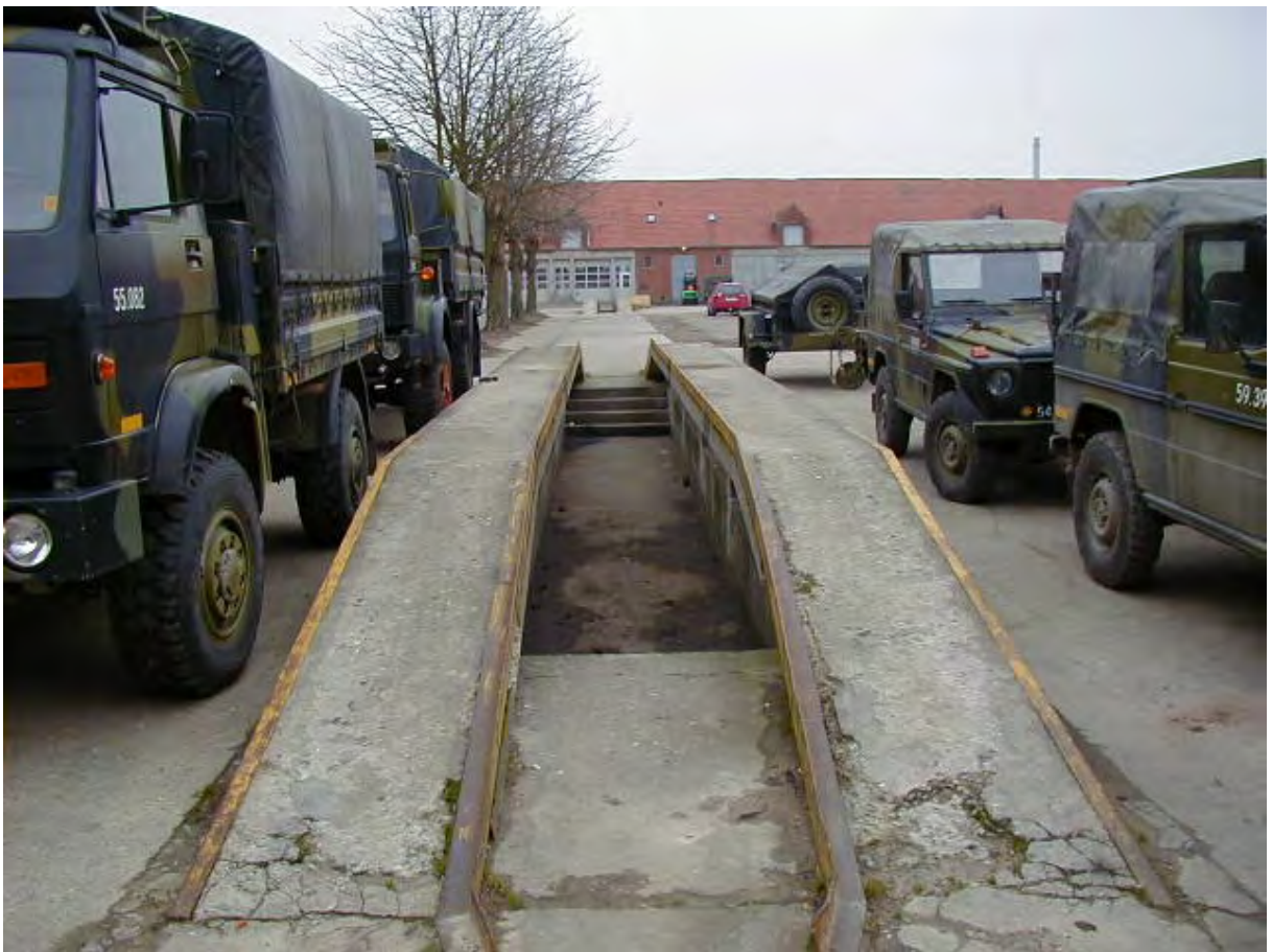
GHK20 Rampe (bygning 11).
