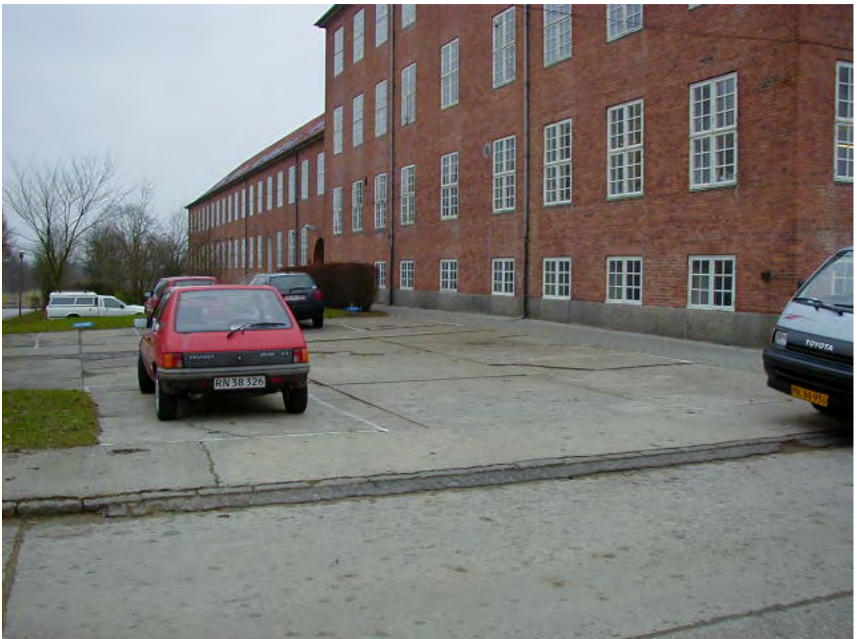
GHK08 Område med 5 nedgravede tanke (bygning 129).
