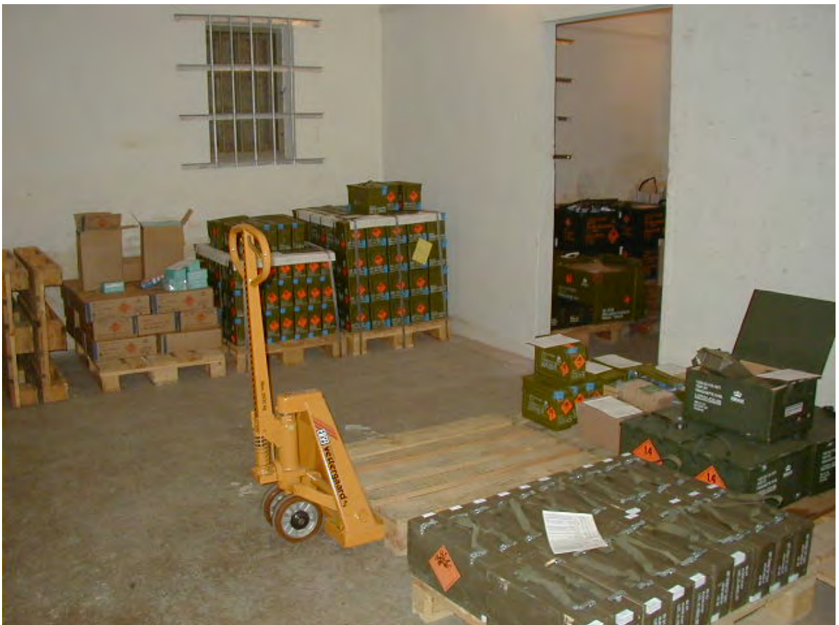
GHK04 Ammunitionsmagasin (bygning 26).
