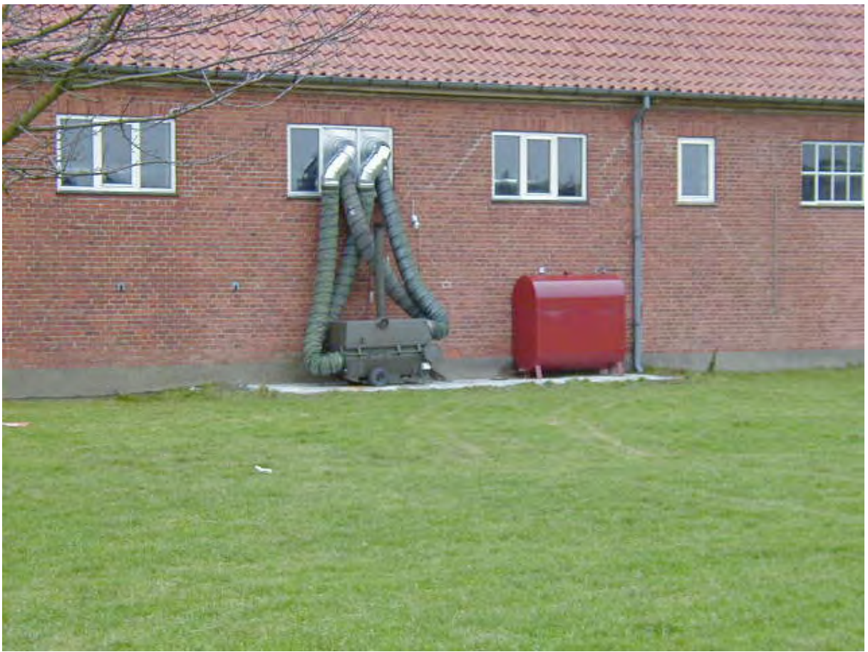
GHK19 Oliefyret varmluftblæser (bygning 106).
