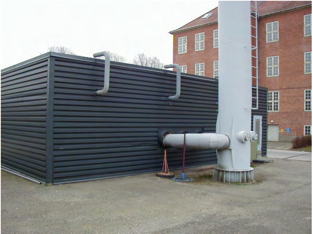
GHK29 Gasfyret varmecentral (bygning 131).
