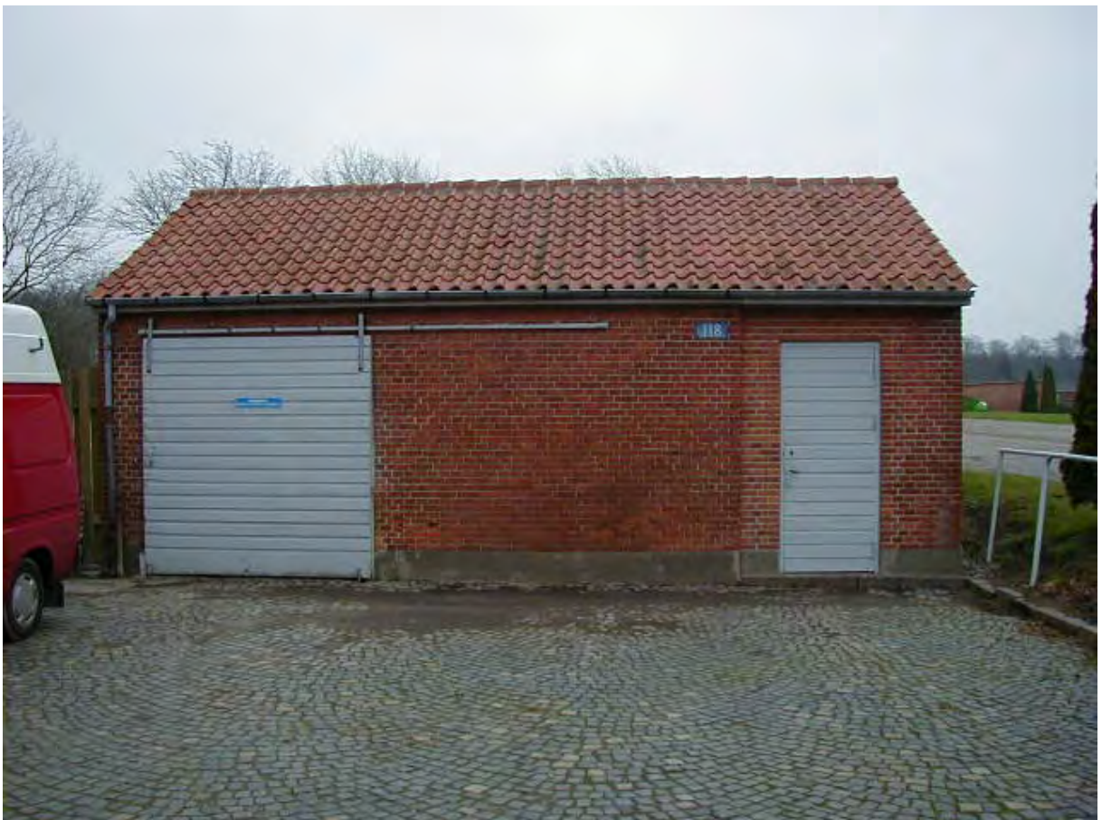
GHK16 Tidligere brandstation (bygning 118).
